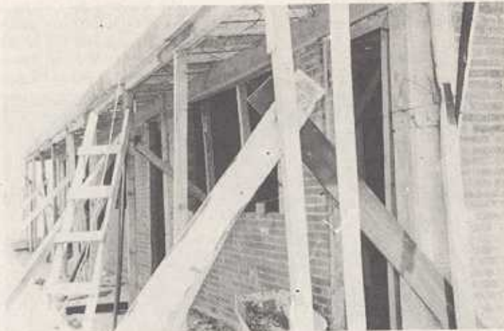
Aspecto de la Construcción de las aulas anexas
